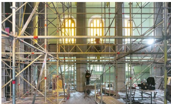
Mitten im Umbau. Foto Simon von Gunten
